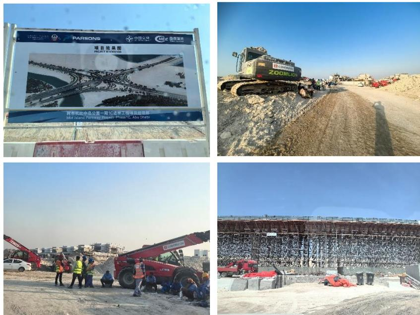
宏信建发在该项目为中国港湾工程有限责任公司提供13台挖掘机、5台叉装车、6台高空作业平台、1,500吨盘扣式脚手架在内的综合设备服务
